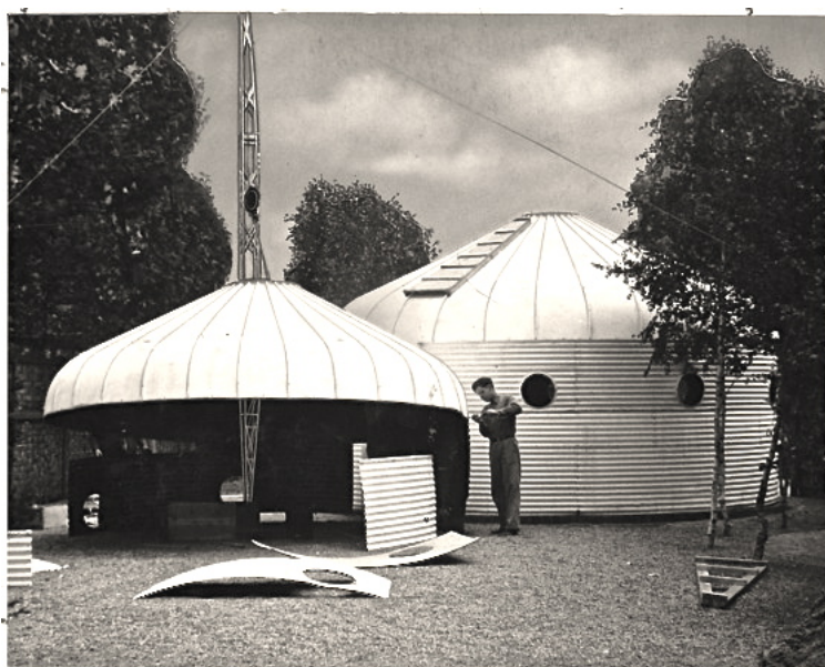
Figura 15. Il montaggio della Dymaxion Deployment Unit , 1941
